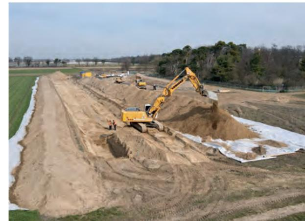
Der eigentliche Sickerschlitzgraben hat eine Endtiefe von 6,5 m und wird bis zur Oberkante mit Filtersand versehen. Darauf werden die Fundamente gesetzt, die anschließend die Winkelstützmauern aufnehmen.
