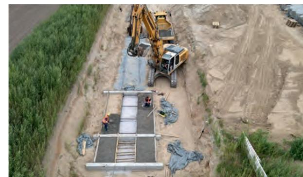
Die Winkelstützmauern werden abschnittsweise errichtet. Dabei müssen die 12,5 t schweren Fertigteil-elemente genau ausgerichtet und positioniert werden. Die umlaufenden Betonelemente bilden dann später einen geschlossenen Sickerschlitzgraben in Form eines lang gezogenen „O“.
